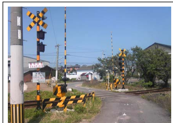
大三東駅構内 第146号踏切
