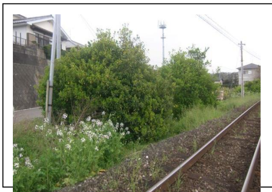
吾妻駅～古部駅間（伐採前）
