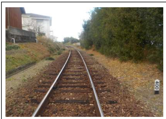
有明湯江駅～大三東駅間 レール交換・マクラギ交換 （施工前）
