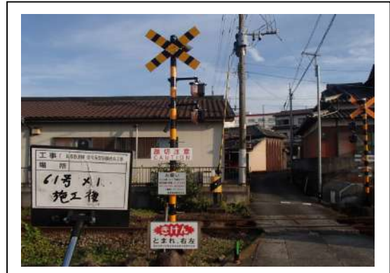
第 6 1 号踏切警報機（施工後）
