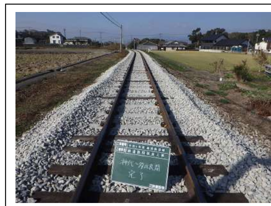
神代駅～多比良駅間 レール交換・マクラギ交換 （施工後）
