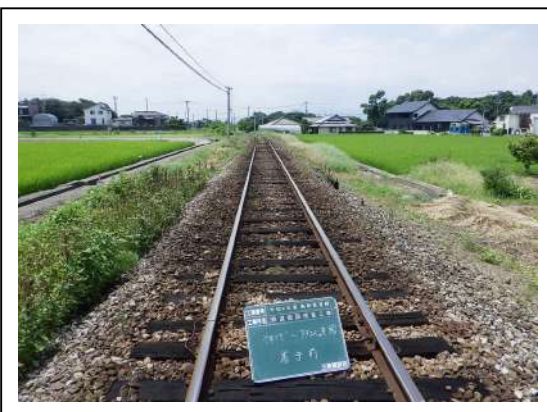
神代駅～多比良駅間 レール交換・マクラギ交換 （施工前）
