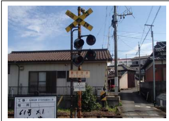
第 6 1 号踏切警報機（施工前）
