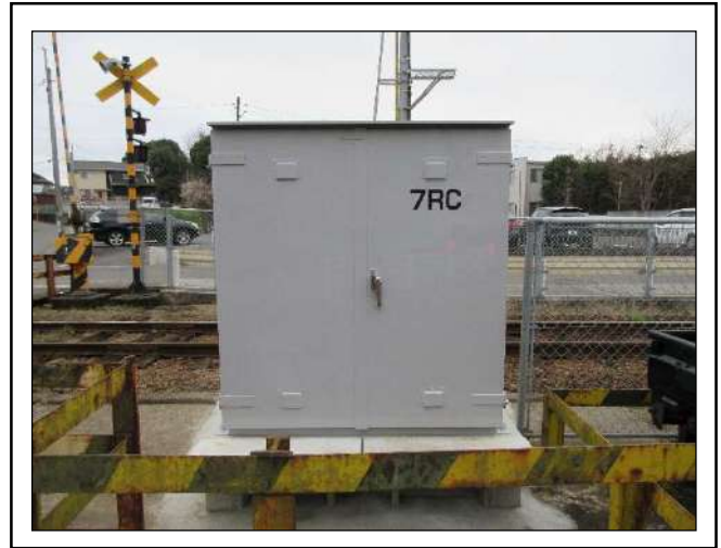
第7号踏切道 踏切信号器具箱の更新（施工後）
