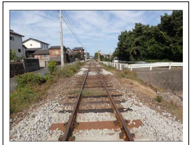
有明湯江駅～大三東駅間 レール交換・マクラギ交換（施工後）
