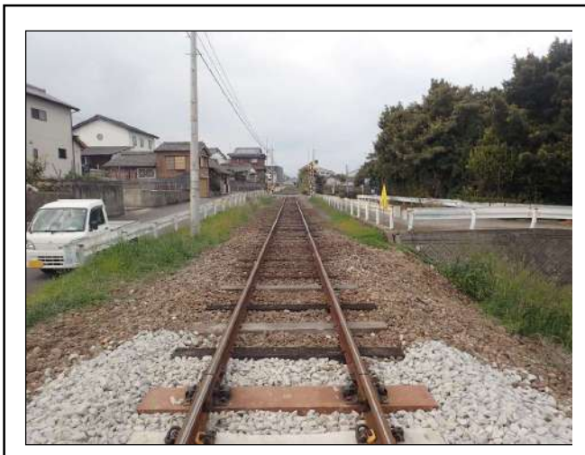
有明湯江駅～大三東駅間 レール交換・マクラギ交換（施工前）
