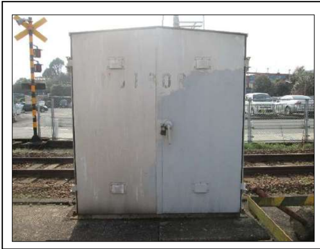
第7号踏切道 踏切信号器具箱の更新（施工前）
