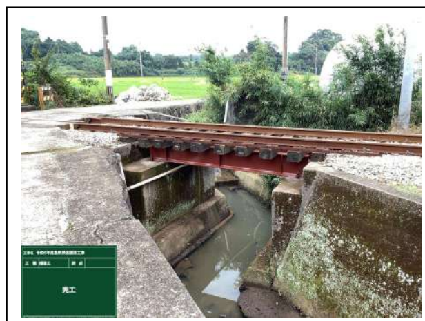
西郷駅～神代駅間 溝橋 橋桁交換及び重防食塗装（施工後）
