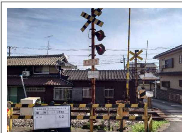
松尾駅～三会駅間 第159号踏切道 踏切警報機の更新（施工前）
