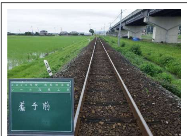
森山駅～釜ノ鼻駅間 レール交換・マクラギ交換（施工前）
