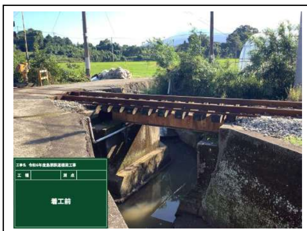
西郷駅～神代駅間 溝橋 橋桁交換及び重防食塗装（施工前）
