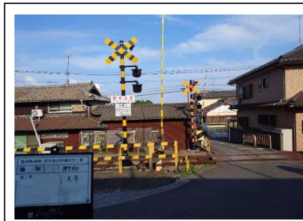
松尾駅～三会駅間 第159号踏切道 踏切警報機の更新（施工後）
