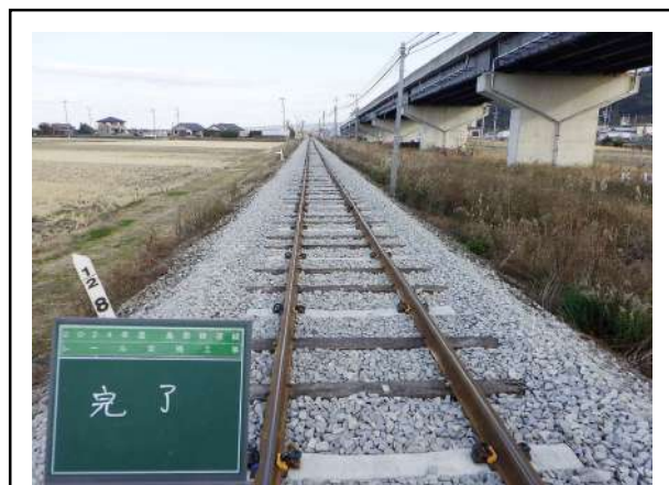
森山駅～釜ノ鼻駅間 レール交換・マクラギ交換（施工後）
