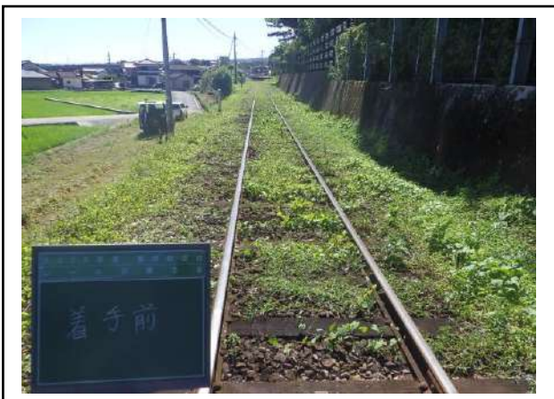
愛野駅～吾妻駅間 レール交換・マクラギ交換（施工前）
