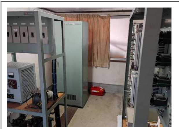
愛野駅 列車集中制御装置更新（施工前）
