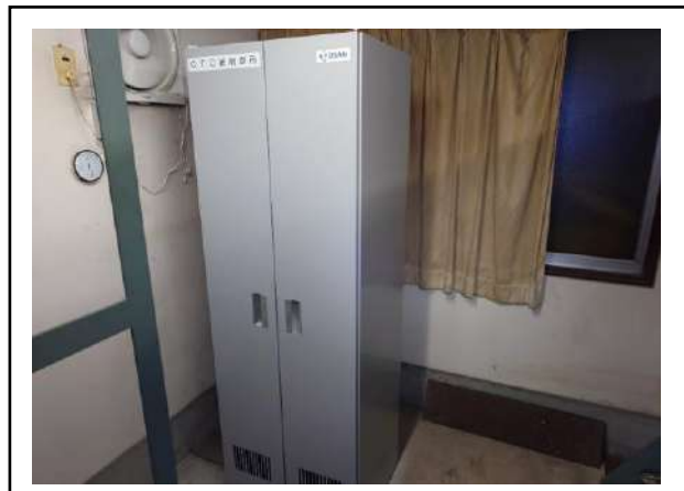
愛野駅 列車集中制御装置更新（施工後）
