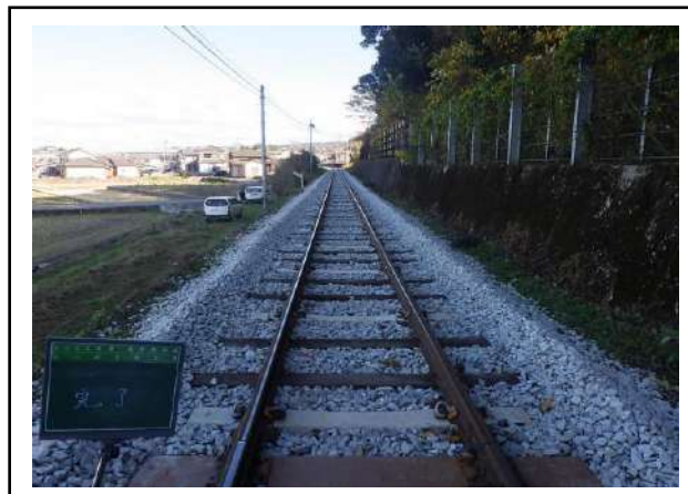
愛野駅～吾妻駅間 レール交換・マクラギ交換（施工後）
