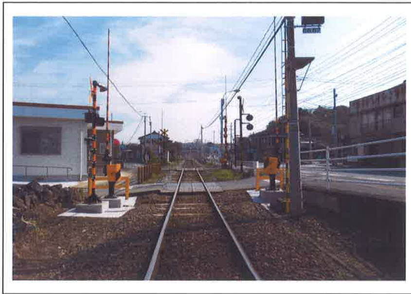
阿母崎駅～吾妻駅間 第66号踏切道 視認性向上のため、LED 全方向型警報灯を採用しています。
