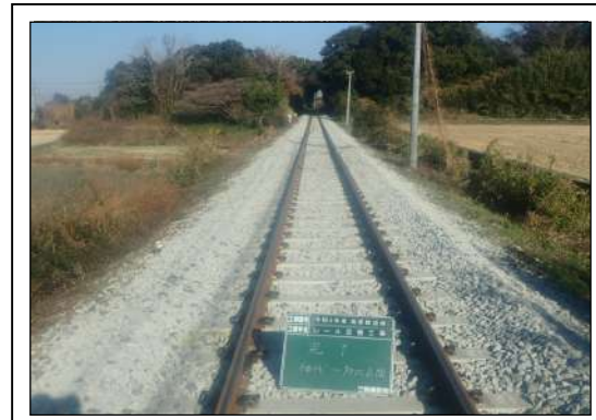
神代駅～多比良駅間 レール交換・まくらぎ交換 （施工後）
