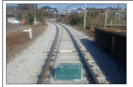
古部駅～大正駅間 レール交換・まくらぎ交換 （施工後）
