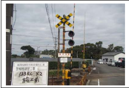
第 123 号踏切警報機（施工前）
