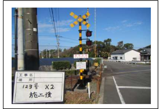
第 123 号踏切警報機（施工後）
