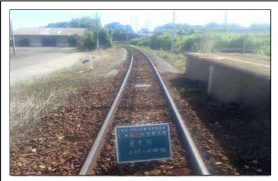
古部駅～大正駅間 レール交換・まくらぎ交換 （施工前）
