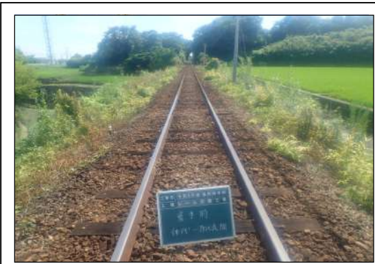
神代駅～多比良駅間 レール交換・まくらぎ交換 （施工前）
